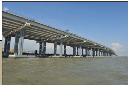
沿江项目工地实景
