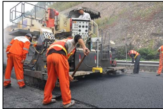
道路养护工程现场
